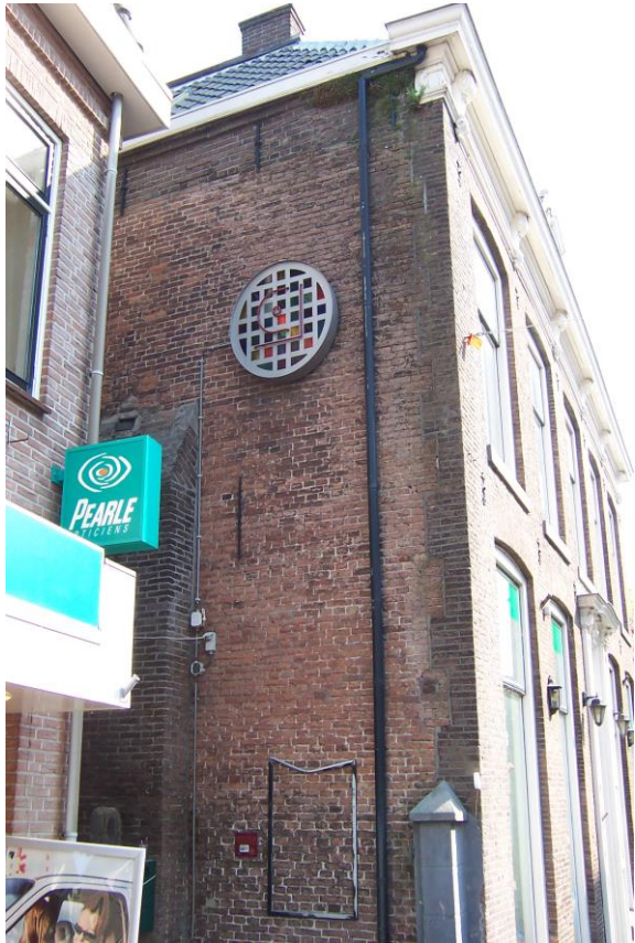
Afbeelding 1: aanzicht linkergevel van de Marskramer (Kerkstraat 8) waarop de bloktanden ter plaatse van de aansluiting voorgevel op zijgevel goed te zien zijn. Rechts onder in de zijgevel is een gedeelte te zien van een gepleisterde pilaster waar een toegangshek op heeft gedraaid.
